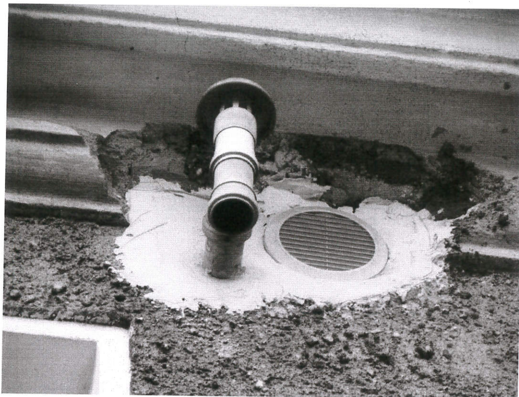
Fot.5. Ubytki w części stropowej od wschodu są uszczelnione (aut. Szymon Wójcik).
